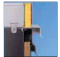
Sobre marcos de escotillas de techo existentes
